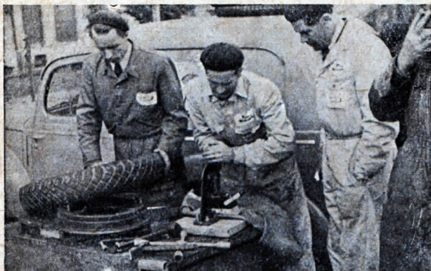
Menší dílničku si Jasovci zařídili podle svého dodávkového Tudora, kde odborně provádějí veškeré opravy a montáže pneumatik. Na obrázku je vulkanisování poškozené duše.
